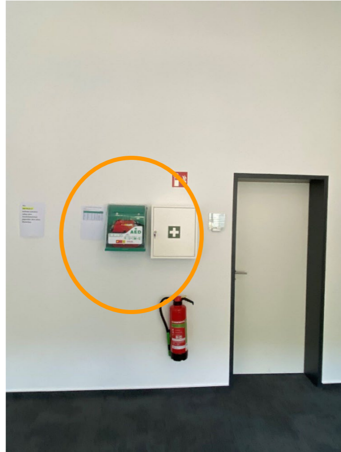
Gebäude 2: im inneren Treppenhaus (vor Büro 0.025)
