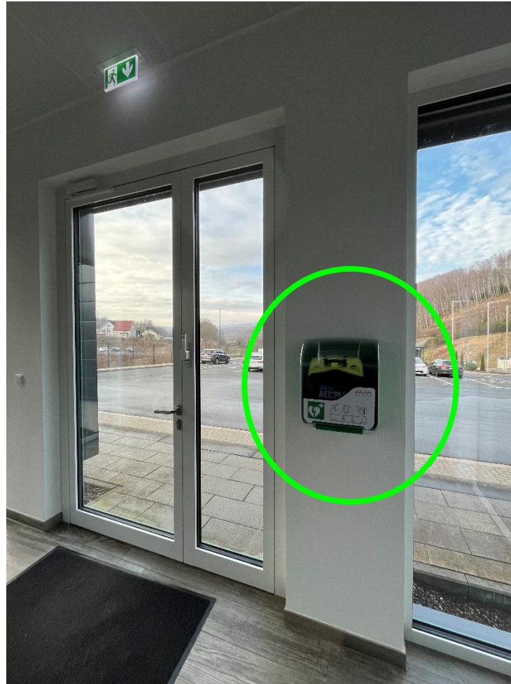
Gebäude 9: Haupteingang (in Schleuse)
