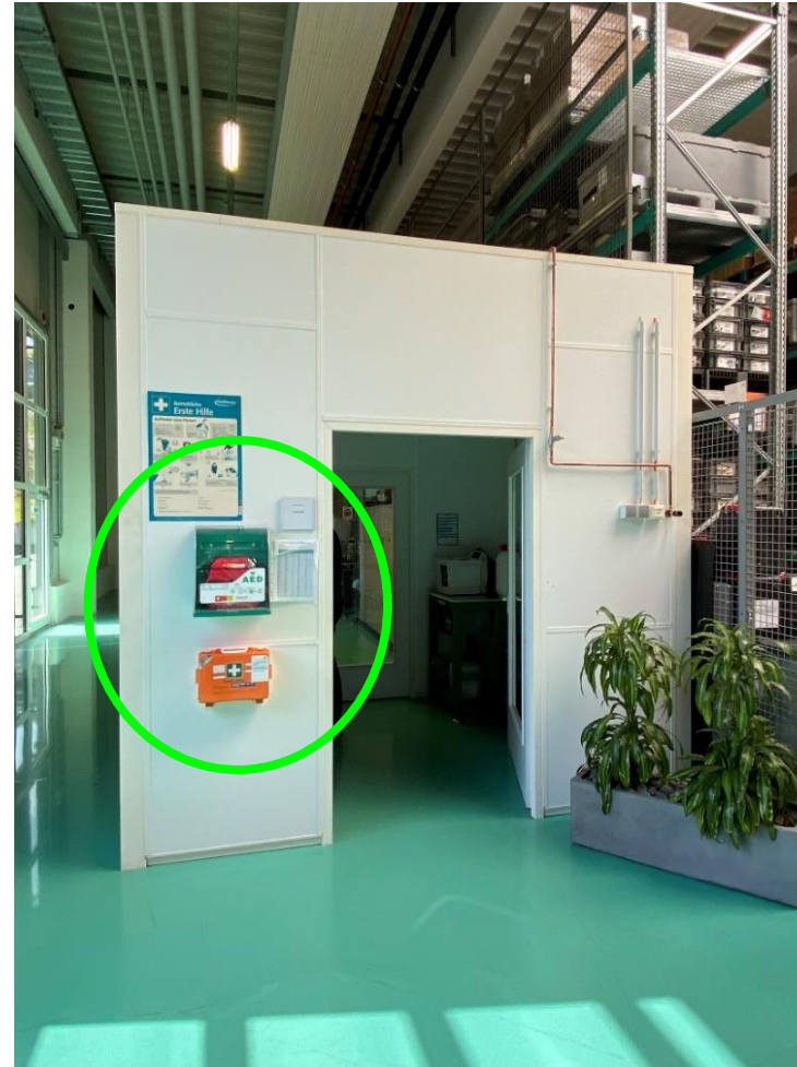
Gebäude 3: an Wand Servicebereich (bei Magazin/Nähe Automaten)
