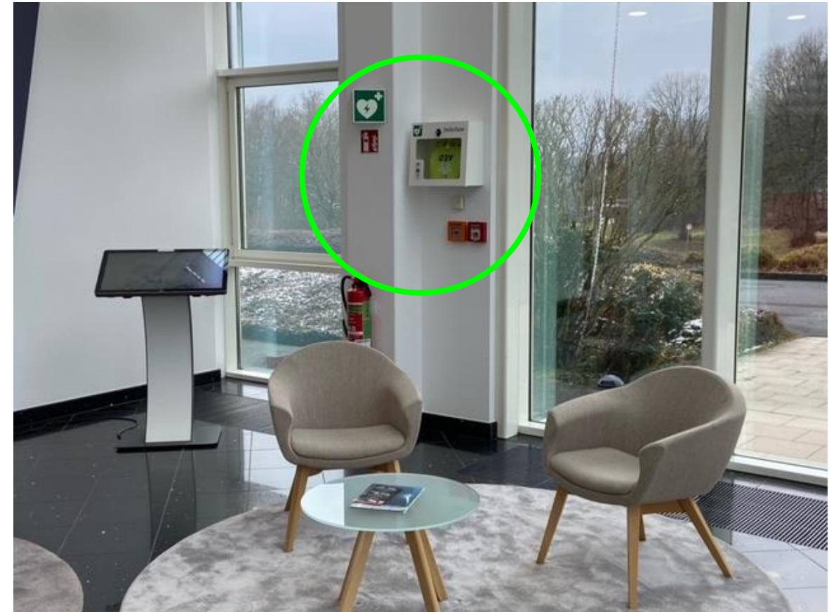
Gebäude 12: im Foyer (Außenwand)
